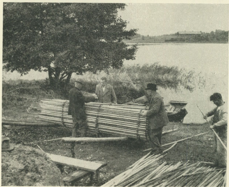
Bild 10—11. Upptill: Golvet vikes samman. Nedtill: Första golvet färdigt att föras ut till katsaståndet.
