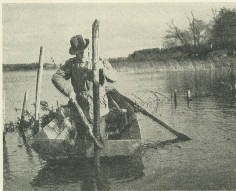
Bild 12—13. Upptill: Man rör ut med första golvet. Nedtill: Påldraget i användning.
