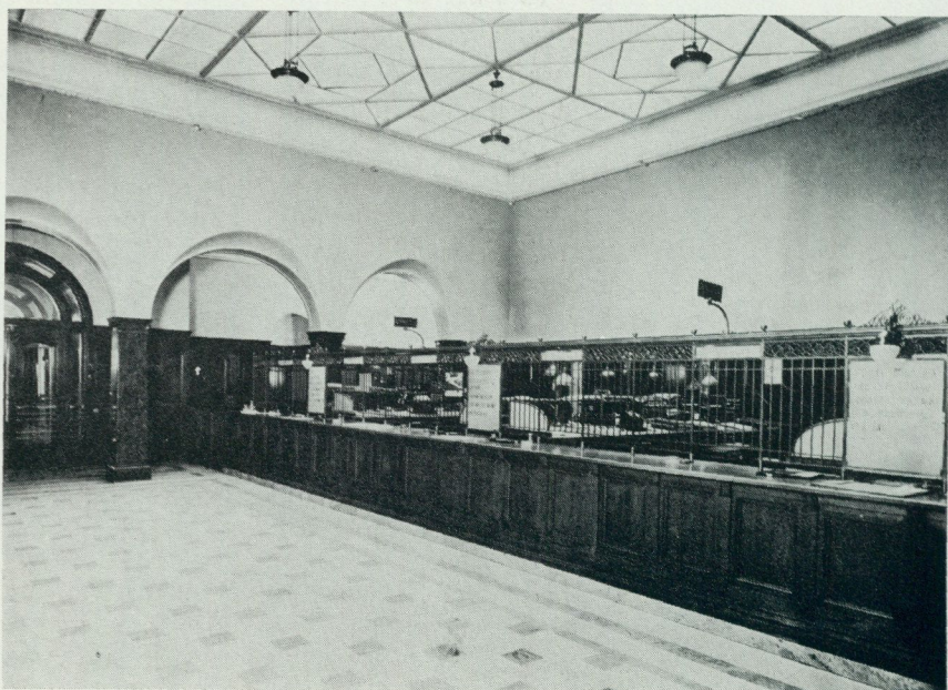
17. Gamla foton av nu ombyggda interiörer till exempelvis bankbyggnader finns ofta i album i företagens egna arkiv, däremot mindre ofta bilder av exteriörerna. Skandinaviska Enskilda Banken, f. d. Södermanlands enskilda bank, vid Fristadstorget i Eskilstuna, uppförd 1910–11 efter ritningar av Ernst Stenhammar. Interiörbilden foto efter original i bankens arkiv.
