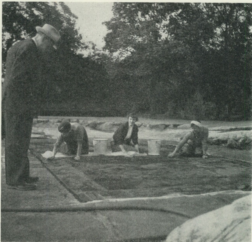
I samband med omdaningsarbetena i museet måste flera av de vävda tapeterna undergå en grundlig rengöring. Här utnyttjas plaskdammen på Skansen som tvättkar för en stor gobeläng.
