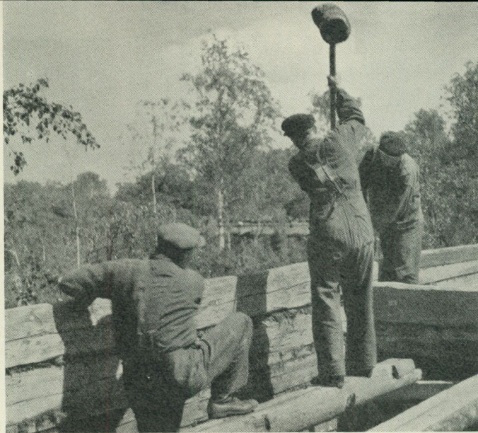
Bild 12. Från återupp- förandet på Skansen. Väggstock i Väster- ängsbyggnaden drives ned i knuthugg och på dymlingarna.
