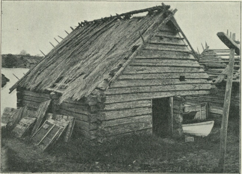
Fig. 31. Sjöbod af B-typ med en dörr och svale. Grisslehamn, Vaddö sn, Uppland.
