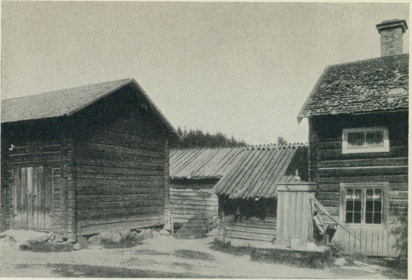
Fig. 42. Brunn med inbyggd pump. Västerby, Regnsjö sn, Hälsingland. Foto byunders. 1920.
