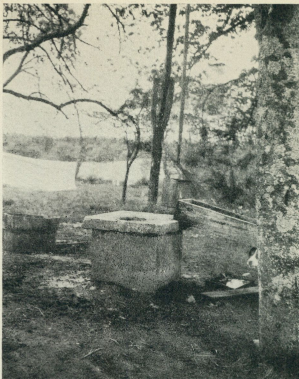
Fig. 18. Brunnskar av öländsk kalksten. Björklycke, Kristianopels sn, Blekinge Foto Sigfrid Svensson 1924.
