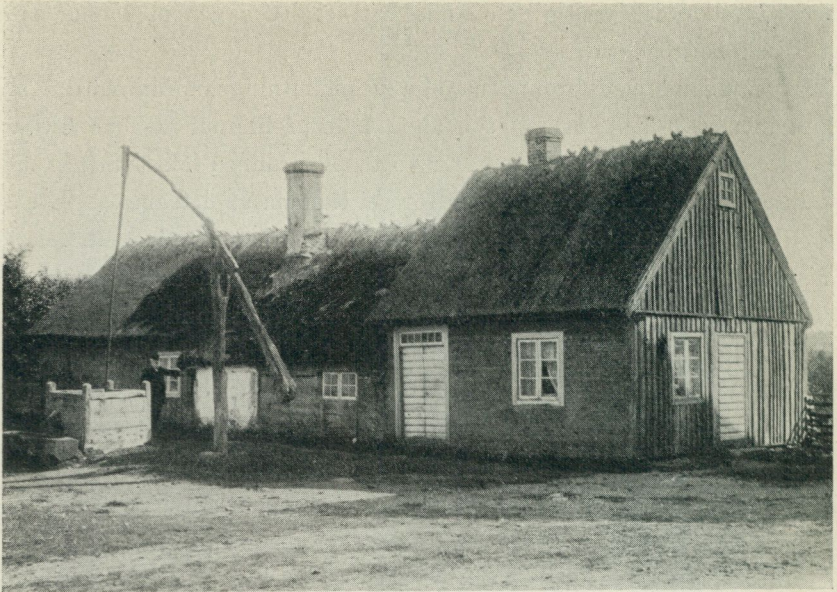
Fig. 25. Brunn med stolpvind. Kolstrarps by, Häglinge sn, Skåne (Krist. län). Foto Axel Nilsson 1897.
