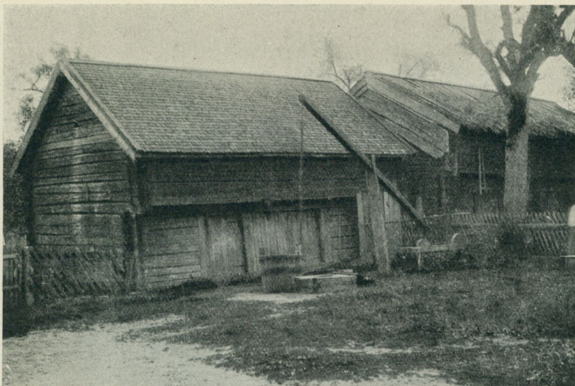
Fig. 27. Brunn med stolpvind. Haddarp, Lönneberga sn, Småland (Kalmar län). Foto A. Nilsson 1904.
