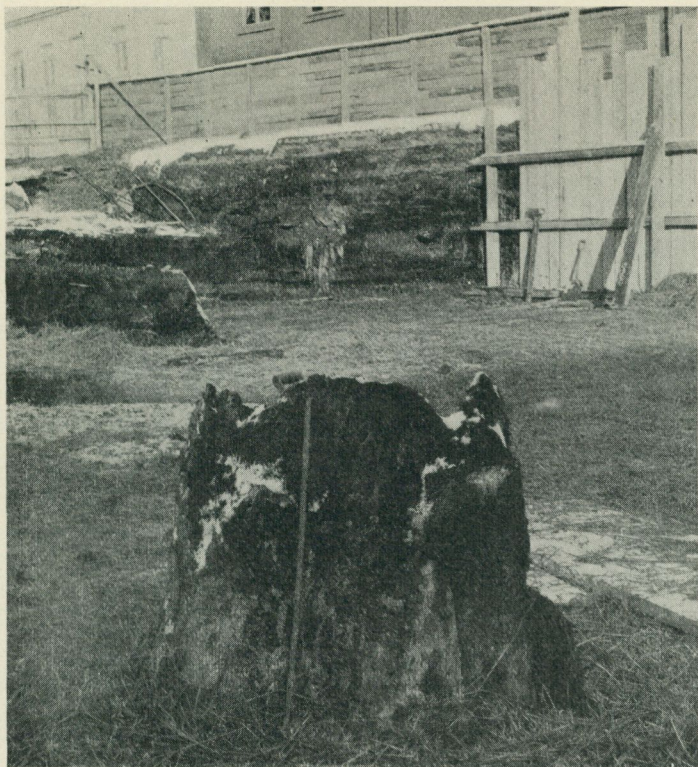
Fig. 11. Brunnsskoning av en urholkad ekstam. Västerås. Foto Västmanlands fornminnesförening.
