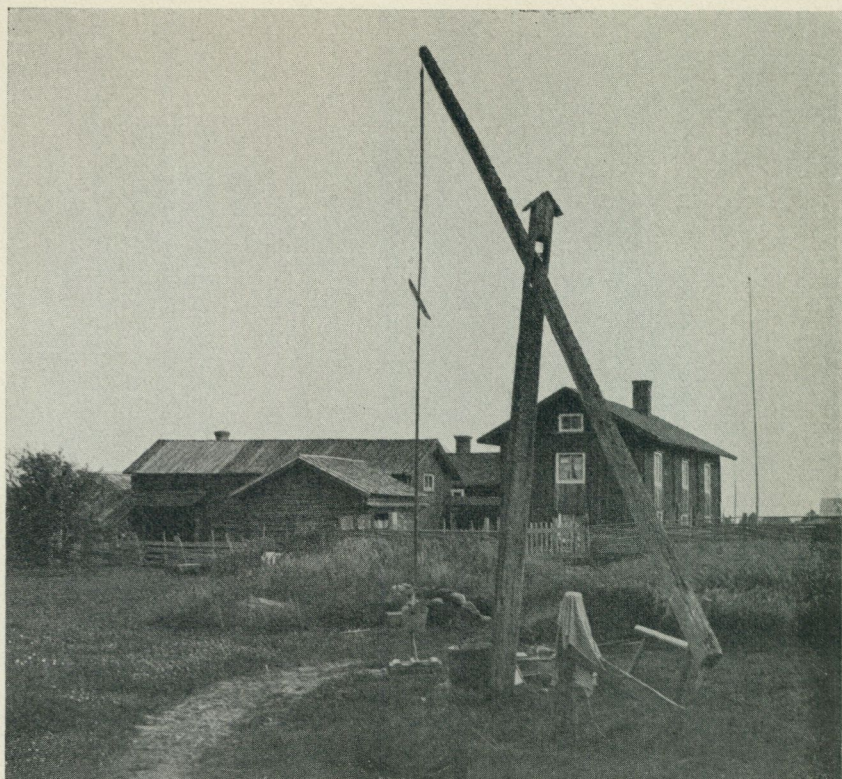
Fig. 29. Brunn med stolpvind. Matsgården, Östbjörka, Rättvik, Dalarna. Foto byunders. 1926.
