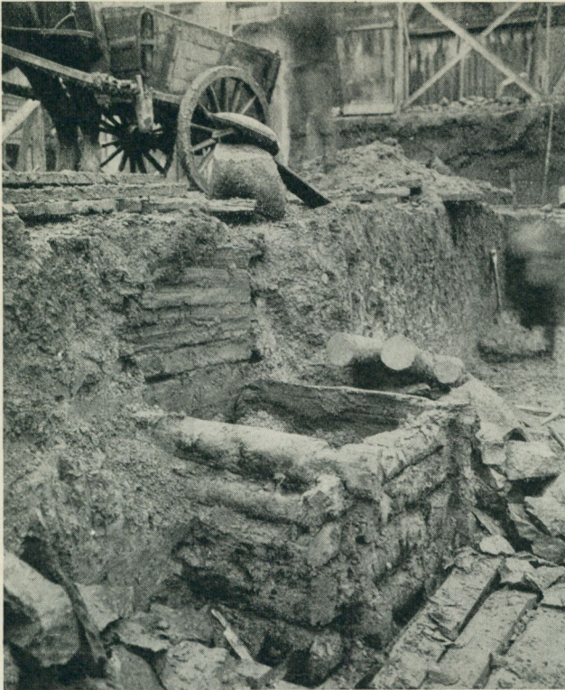
Fig. 15. Knut-timrad brunnsskoning. Kvarteret Murmästaren 3, Hantverkaregatan 19, Stockholm. Foto Gösta Selling.
