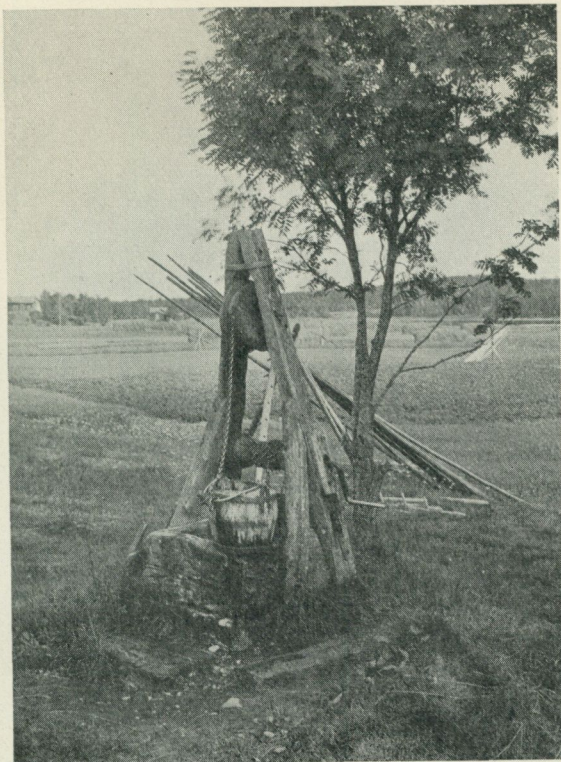
Fig. 37. Brunn med vindspel och hisshjul. Jofs Eriks gård, Landboby, Venjan, Dalarna. Foto byunders. 1926.
