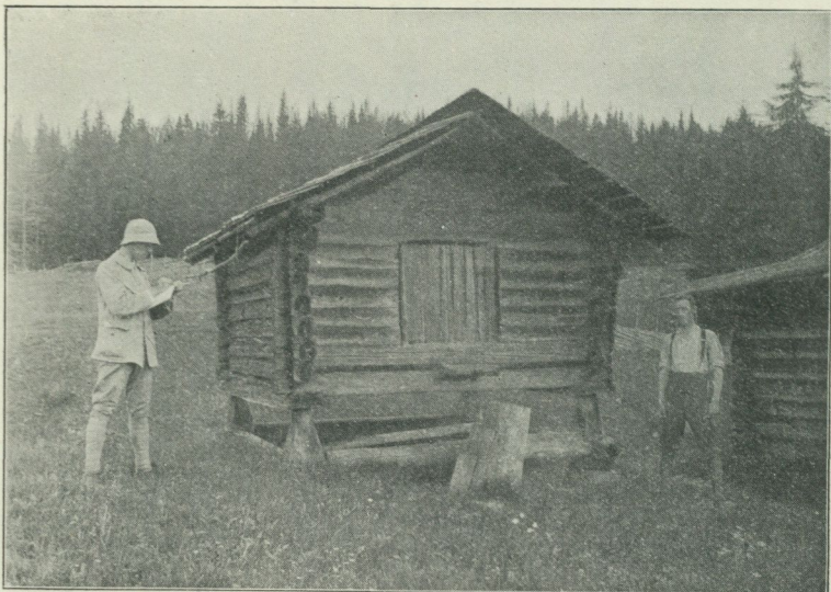
Fig. 17. Stolpbod. Tennbodarna, Älfdalen, Dalarna.
