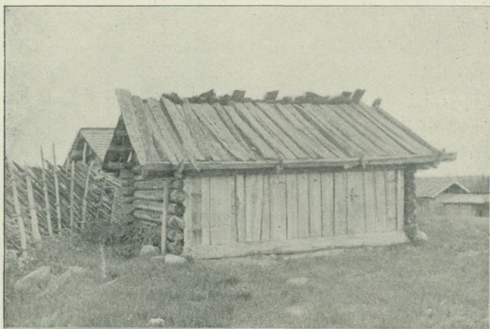
Fig. 1. Stall med stafkonstruktion. Hedbodarnas fäbod, Älfdalen, Dalarna.
